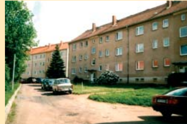
Die Häuser Goethestraße 28 und 30 vor ihrer Außendämmung. Der hintere Block ist bereits fertig
