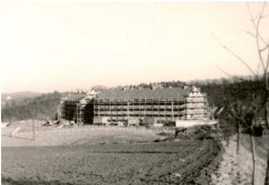
Wolframsdorfer Straße 30 und 32 im Bau
