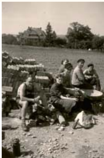
Ausschachtungsarbeiten am ersten Block Rabenauer Straße, im unteren Bild ist das geliehene Förderband zu sehen
