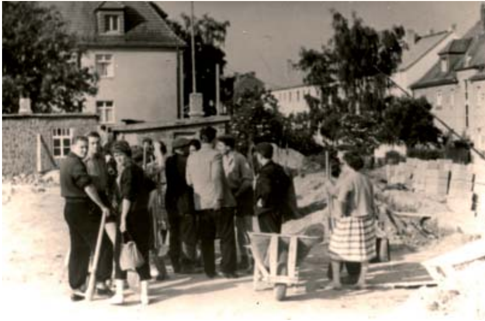
Bauberatung an der Goethestraße 20–22 (1961)
