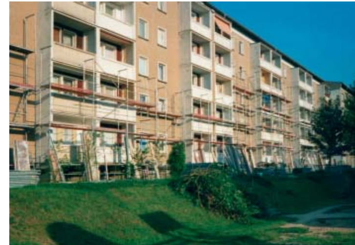
Vorbereitung zur Fassadendämmung im Neubaugebiet (1995)
