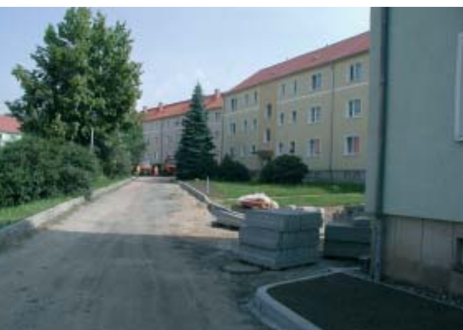
Erneuerung der Versorgungsstraße
