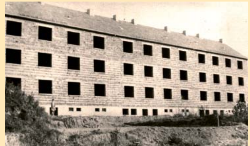
Der Block ist rohbaufertig
