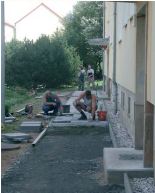
Wegebau im Rahmen der Trockenlegungsmaßnahmen auf der Goethestraße vor den Häusern 20 und 22
