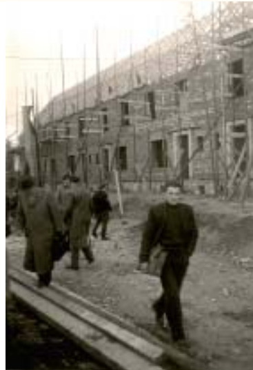
Richtfest am ersten Block Rabenauer Straße
