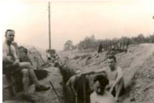
Ausschachtungsarbeiten für den Block Goethestraße 20–22 (1961)
