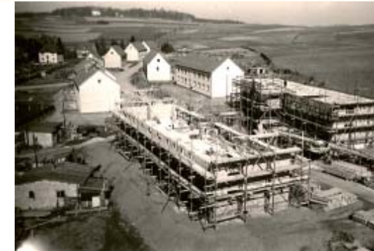
Heideweg im Bau, im Hintergrund die Einfamilien-Reihenhäuser
