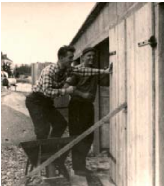
Die Brüder Rossin beim Bau ihrer Garagen
