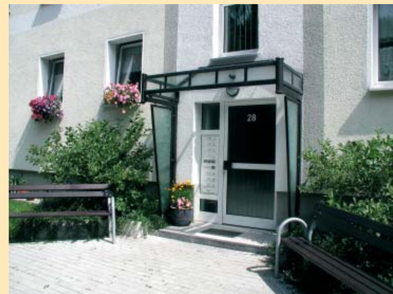
Ähnlich wie vor der Talsperrenstraße 28 sind seit 2003 alle Hauseingänge dieser Straße gestaltet
