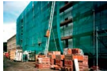
Fassadendämmung auf der Talsperrenstraße (1995)
