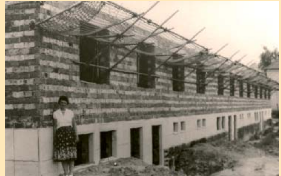
Irmgard Datz vor dem Rohbau des Erdgeschosses
