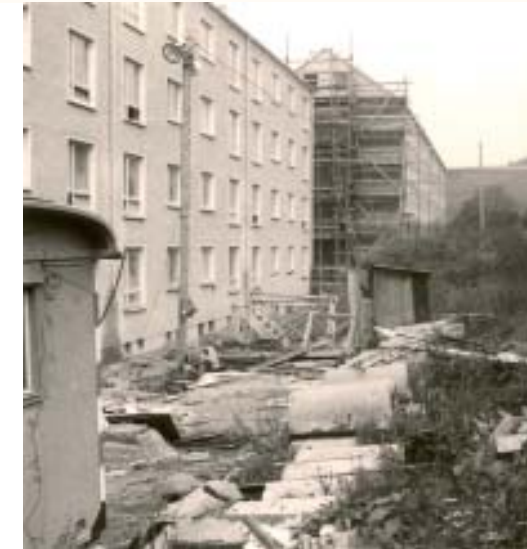
Hinteransicht beim Bau der Talsperrenstraße 24–30
