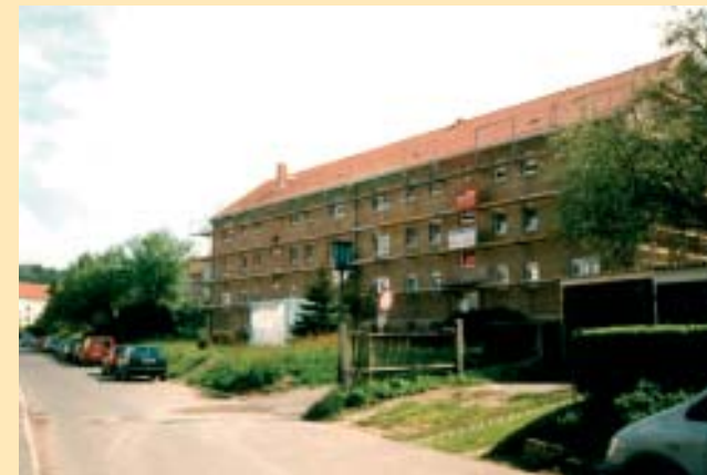
Der Block Goethestraße 20 und 22 während der Sanierung der Fassade
